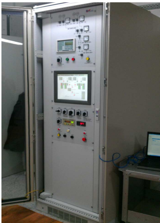
Rys. 1. System MUW-Plus do nadzoru pracy układów wyspowych
